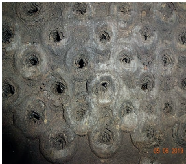
Рис.3 Теплообменник до и после чистки с использованием ТМС-К.
